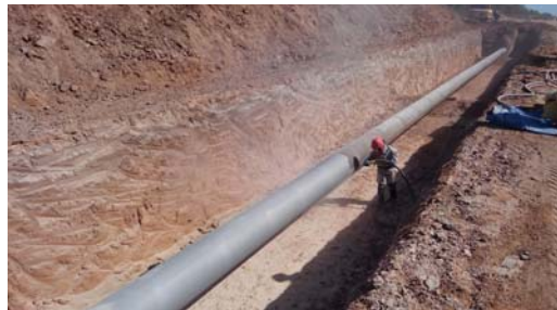
Sand blasting to SSPC-SP-10.
